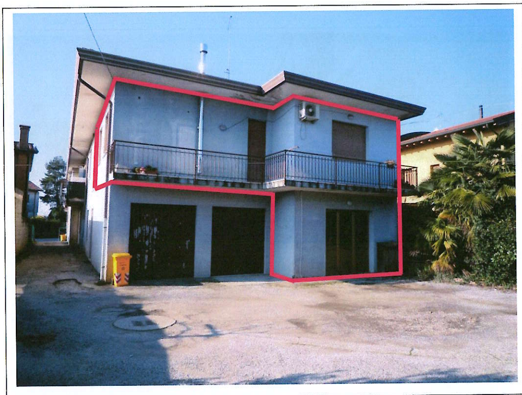
Vista fronte nord-est appartamento piano primo e area di manovra
