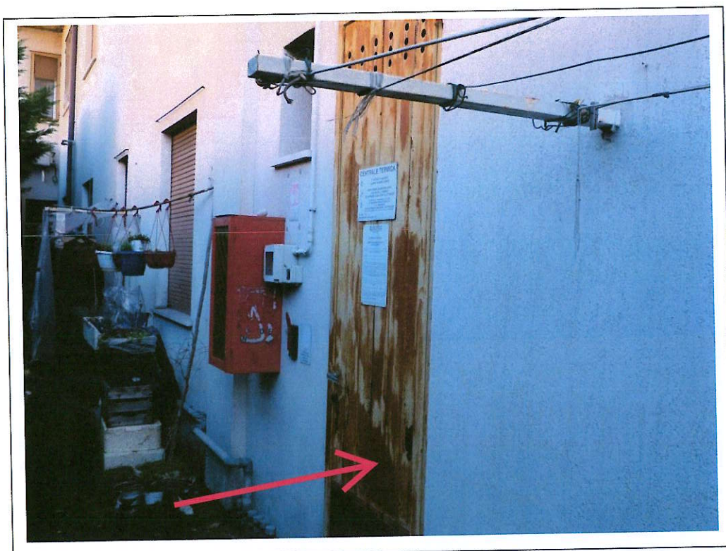
Vista porta metallica della centrale termica sul lato sud-ovest del condominio
