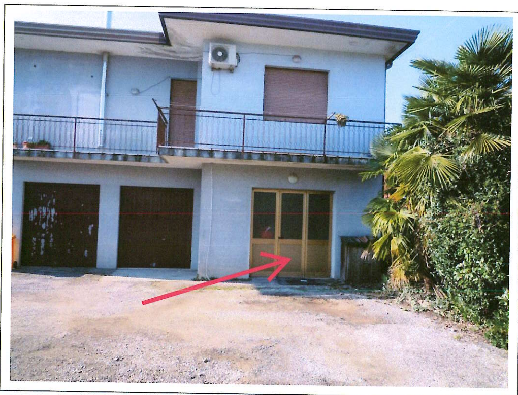
Accesso garage con serramento di alluminio e vetro
